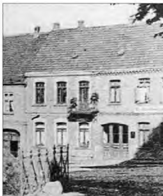
Auf der historischen Aufnahme erkennbar ist auch der Balkon an einem der Fenster.
