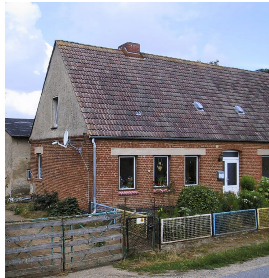
Das Haus in Büschow vor der Sanierung.
