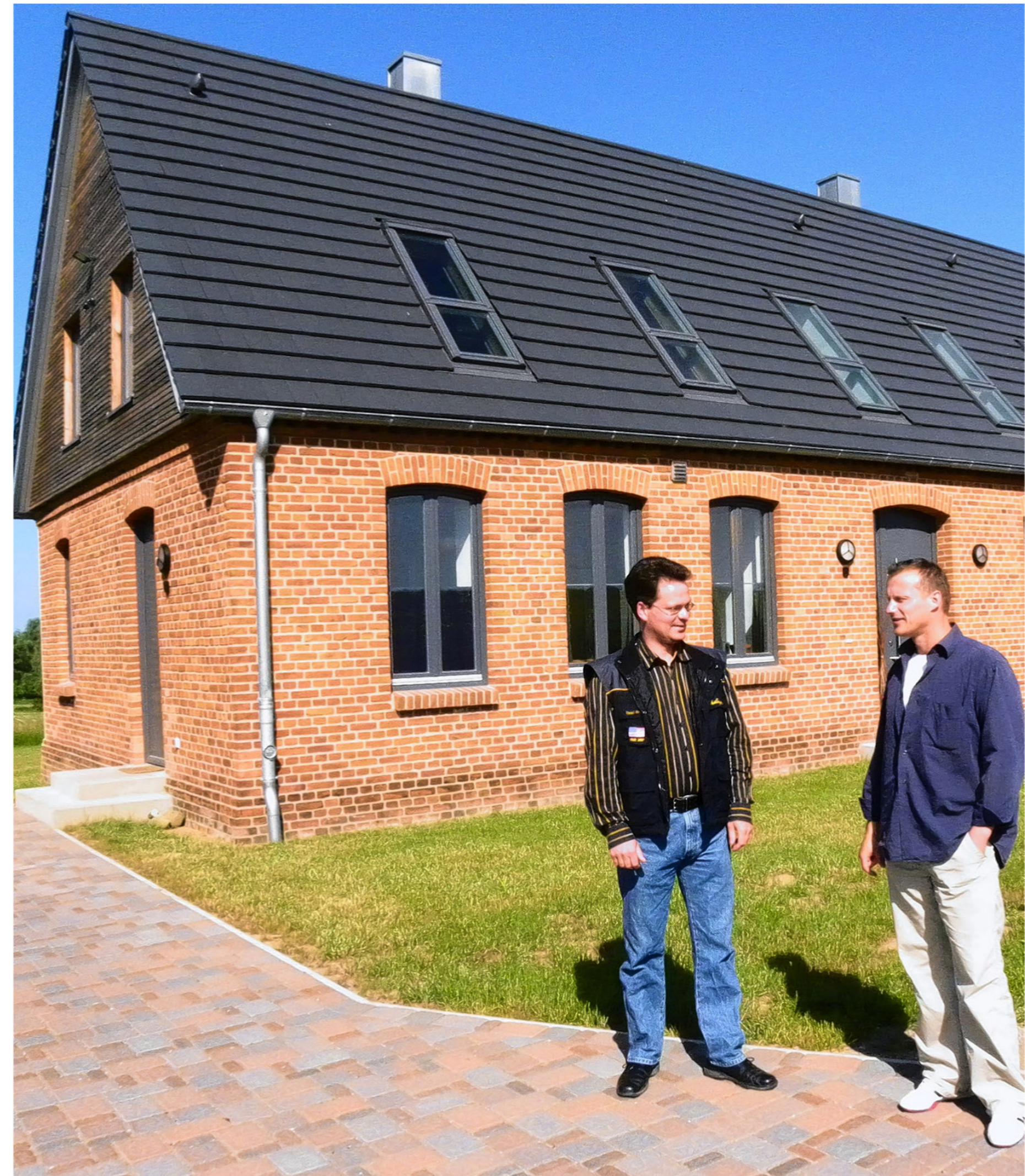
Bauherr Daniel Bohl (l.) und Dipl.-Ing. Marco Scheffler von der Lüders Architekten GbR vor dem sanierten Wohnhaus in Büschow. Am Sonnabendnachmittag ermöglicht der Bauherr Interessenten einen Blick in die Ferienwohnung. FOTOS: ROSWITHA SPÖHR (2)
